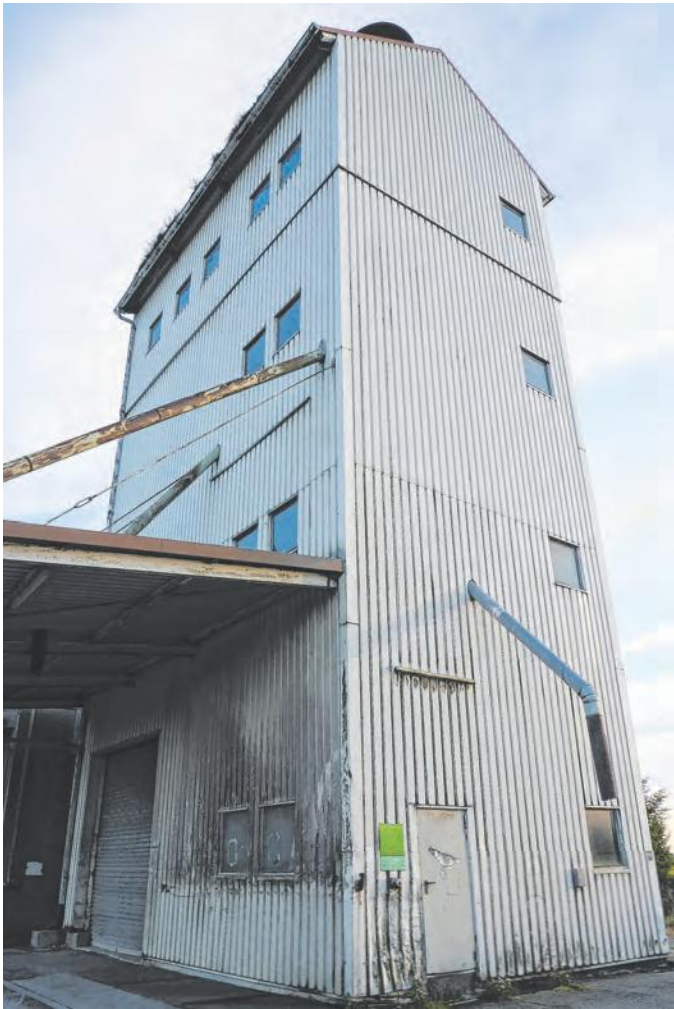
Der ursprüngliche WLZ-Getreidelager-Turm.
