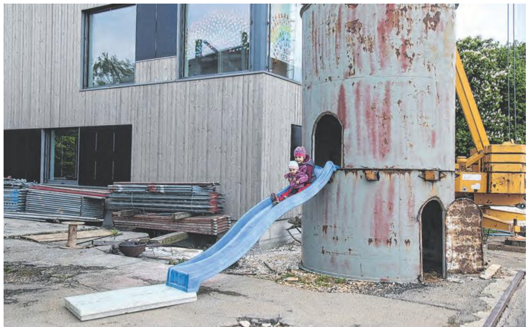
Aus einem alten Silo auf dem Gelände vor dem Haus hat Benjamin Eisele seinen Töchtern einen Spielturn gebaut.
